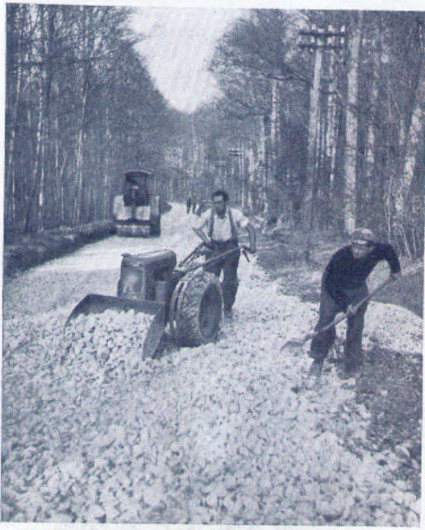
Mit Räumschild beim Schottervertellen
