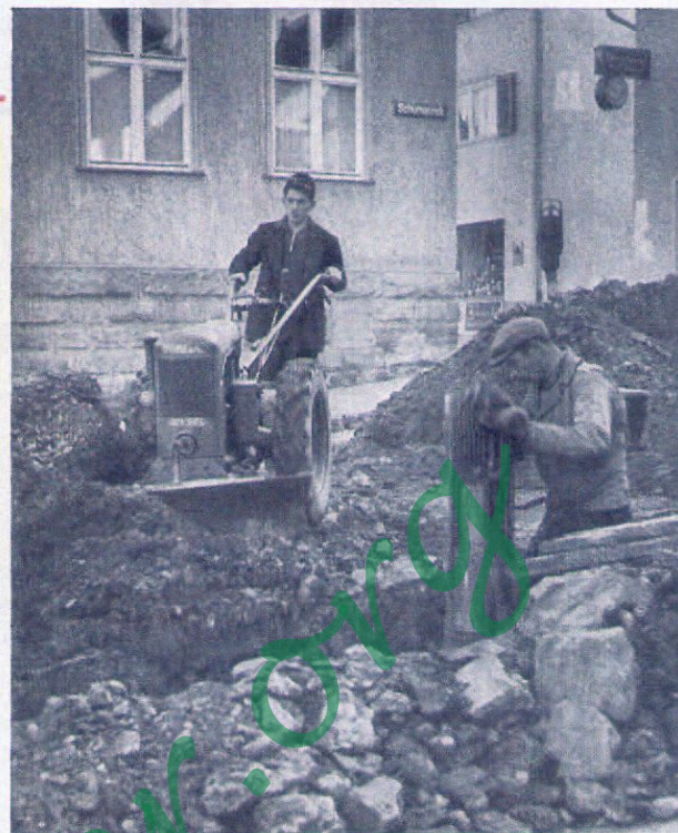
Mit Planierschild beim Zuschieben von Gräben
